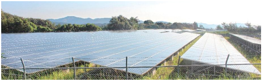
稼働中のこうち・くろしお太陽光発電(株)のソーラーパネル(入野地区国営農地)
