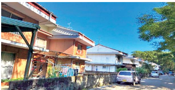
浜松改良住宅
