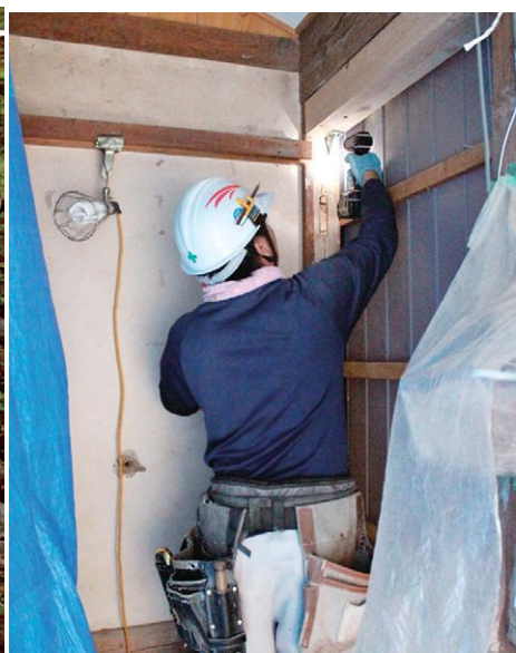
補助金を活用した家屋の耐震改修工事。補強材と柱を「柱頭金具」で固定中
