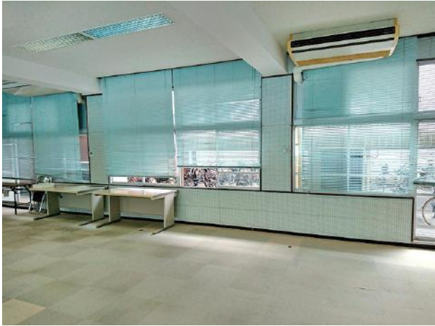
パーティション設置予定の空き教室（大方中学校）
