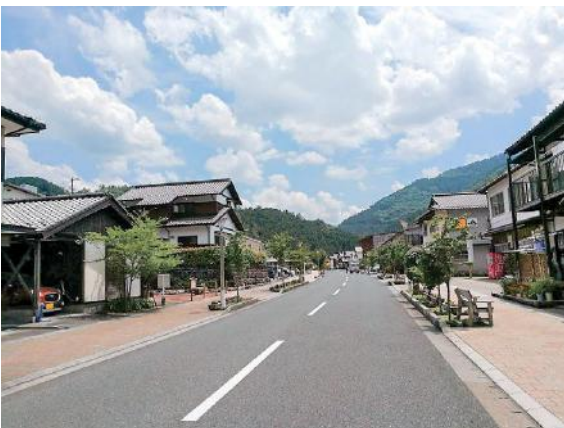
無電柱化によりスッキリとした町並み。防災面からも安心度アップ（梶原町）
