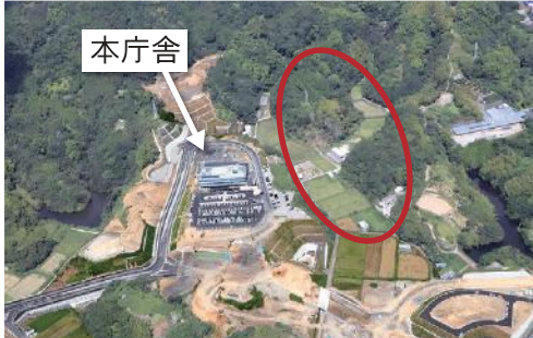
入野地区の高台造成事業候補地（赤枠付近）
