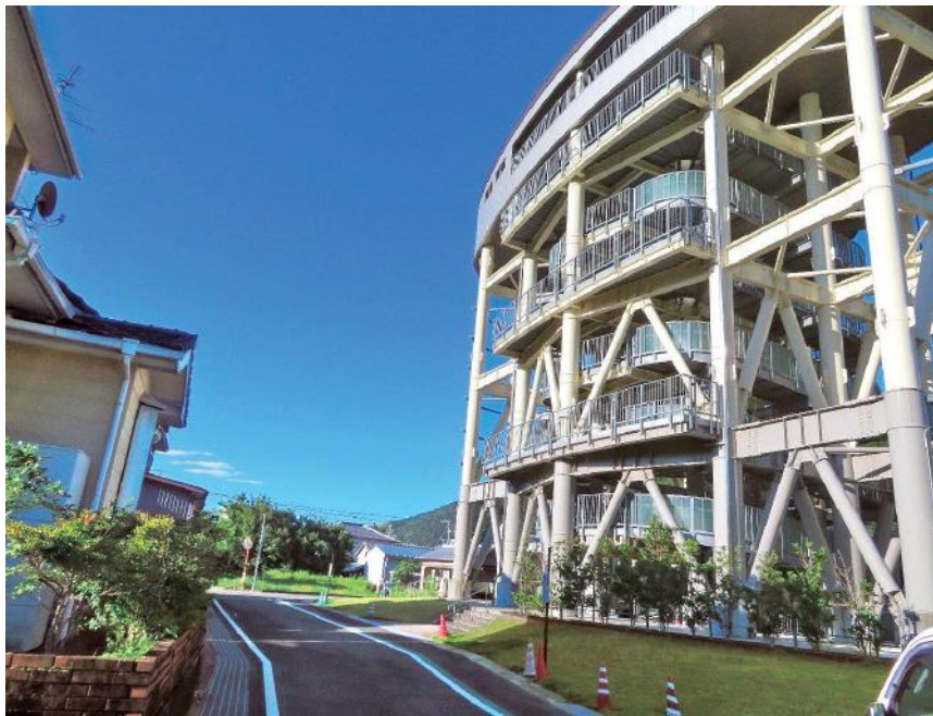
垂直式救助袋が設置された佐賀地区避難タワー
