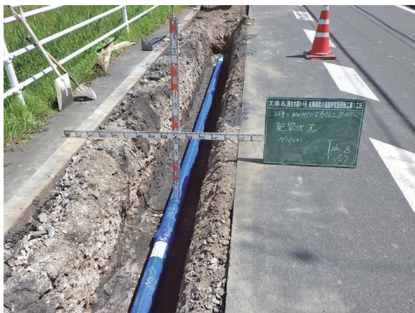
佐賀地区の耐震性配水管の埋設工事
