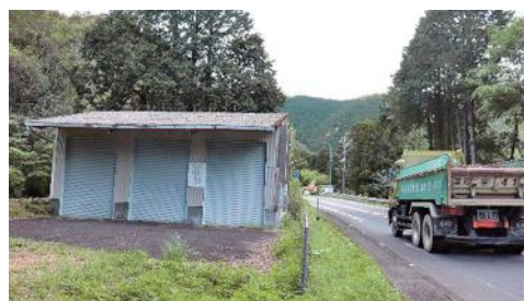
機械施設の格納庫（不破原）
