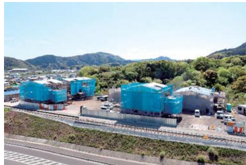
建設中の万行第1第2町営住宅治いの町道も社会資本整備事業で
