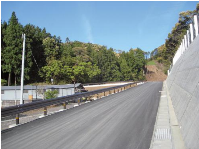
社会資本整備事業により工事が進む大井川馬荷線
