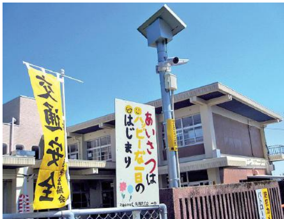
子供見守りカメラ(入野小学校)
