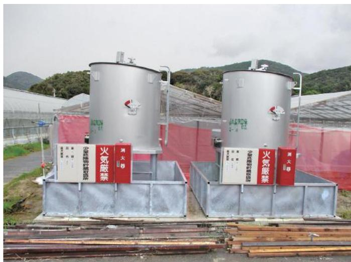
津波浸水区域内のハウスに設置の耐震性燃料タンク
