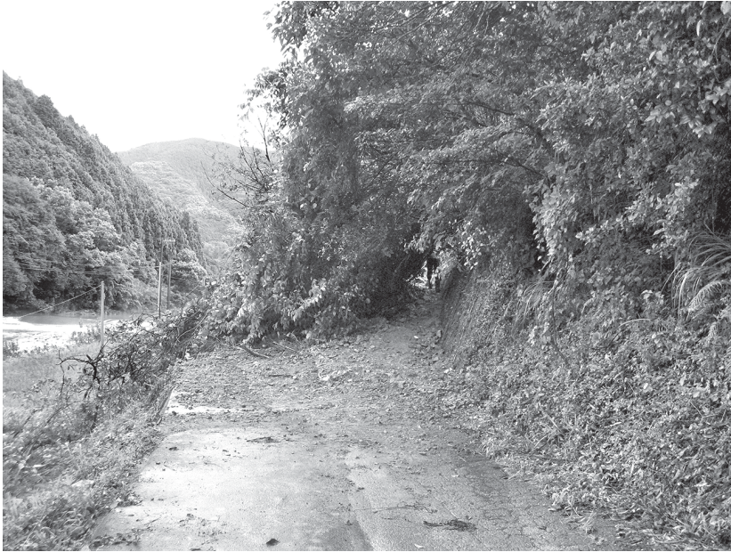
集落の一部が孤立した町道湊川線の崩落現場（9月12日、早朝）
