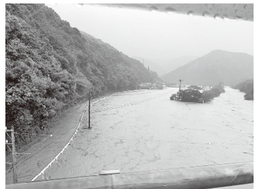
氾濫した伊与木川（令和2年9月11日）
