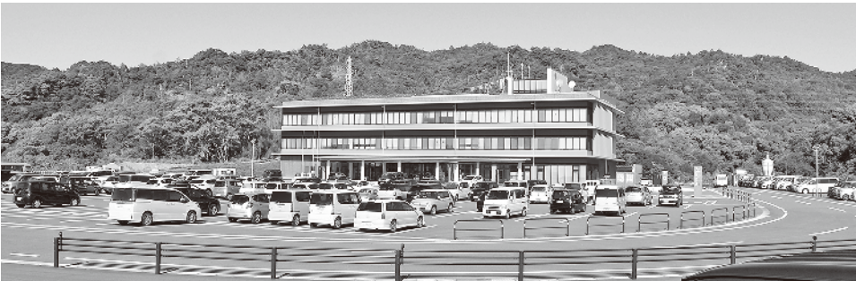
本庁舎（令和2年9月）
