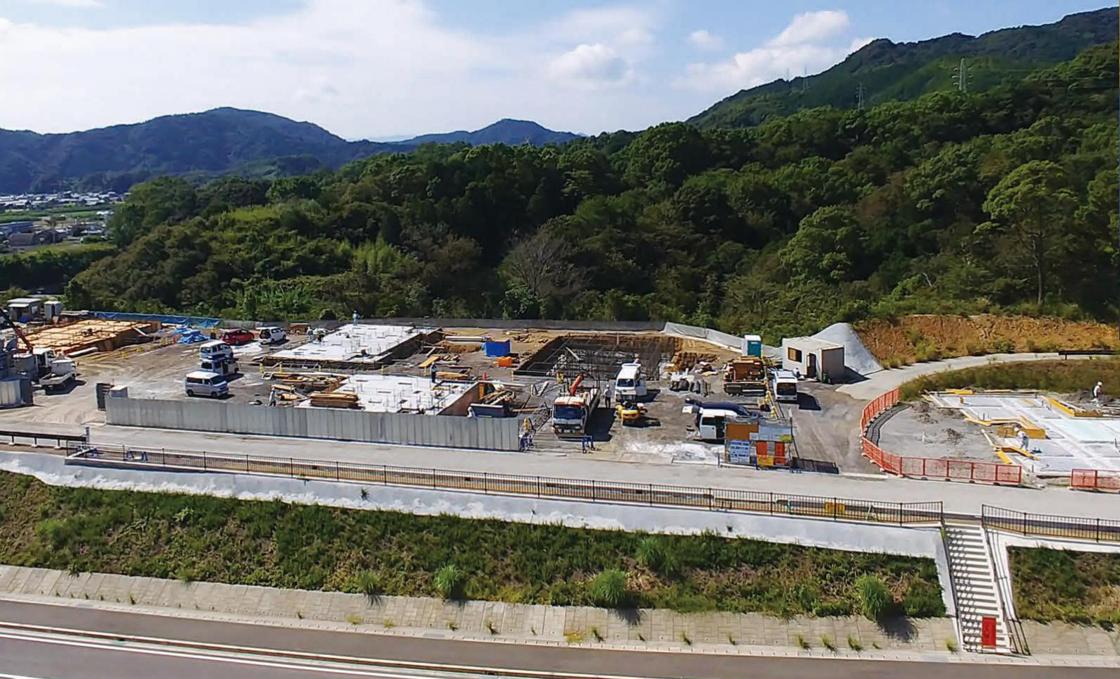
工事中の、万行第1・第2団地(本庁舎屋上から撮影)
