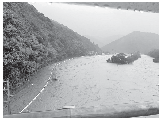
氾濫した伊与木川（令和2年9月11日）
