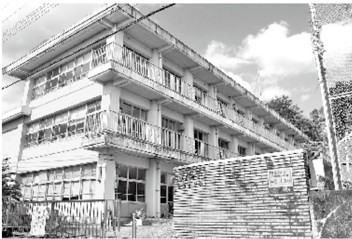
町内6力所目のあったかふれあいセンター 開設予定の旧伊田小学校
