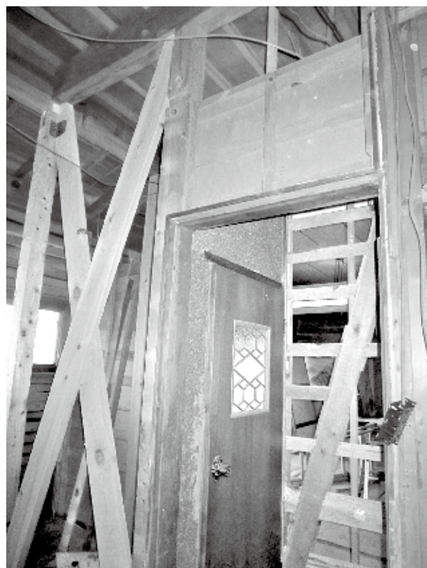
住宅耐震改修工事中
