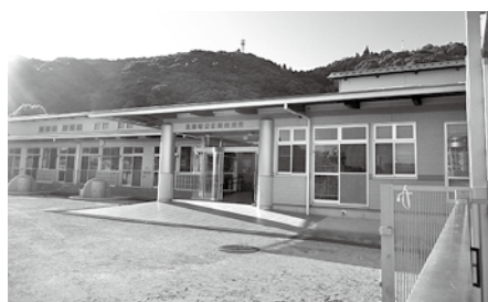
黒潮町立交流センターみらい
