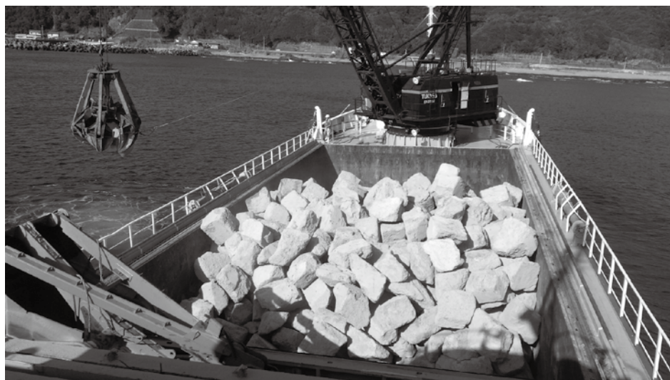
作業船による投石魚礁設置作業の一コマ（灘沖）
