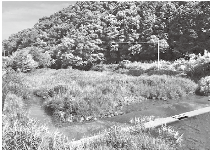
土砂の浚渫が待たれる加持川（加持本村）
