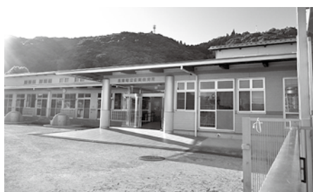
黒潮町立交流センターみらい
