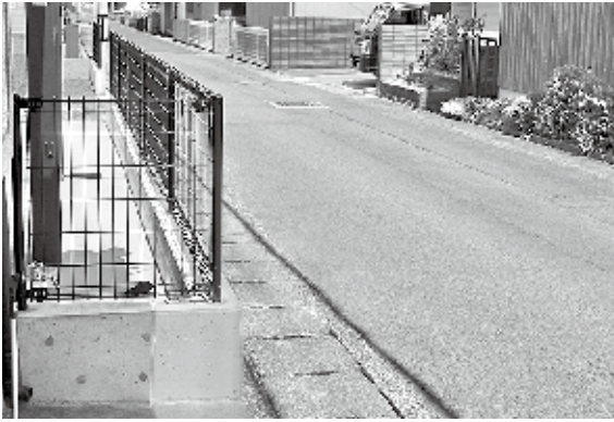
耐震対策でブロック塀を網状のフェンスに (R2年3月)
