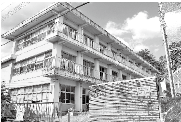
町内6カ所目のあったかふれあいセンター 開設予定の旧伊田小学校
