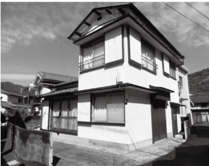
定住促進住宅改修後の外観
