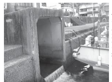
佐賀漁港の排水口
