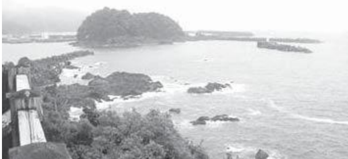
急がれる先端の復旧工事
