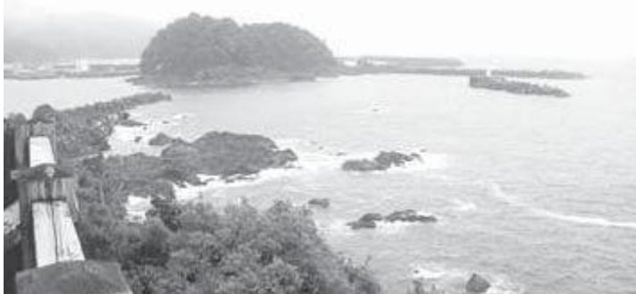
急がれる先端の復旧工事
