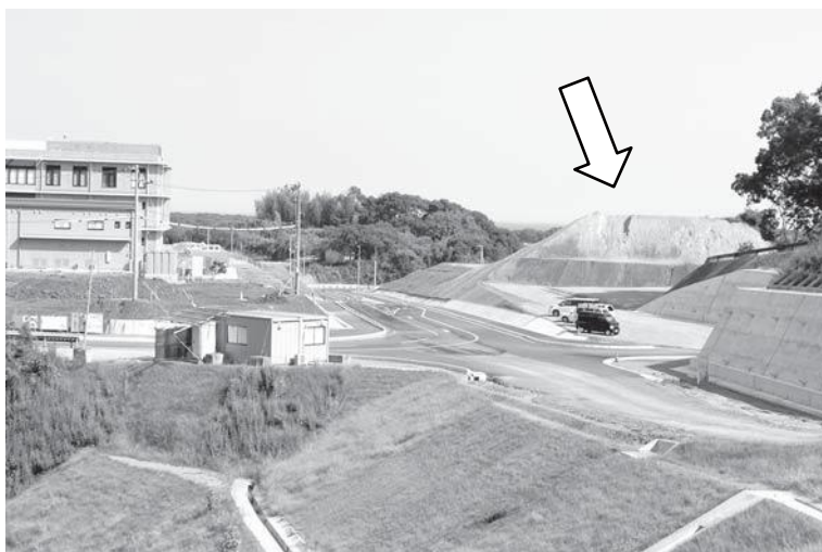
本庁舎西側の万行第一、第二団地移設予定地(矢印の先)
