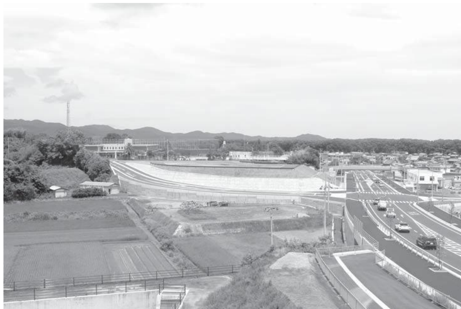
造成された城山団地（中央部）を新庁舎駐車場より望む
