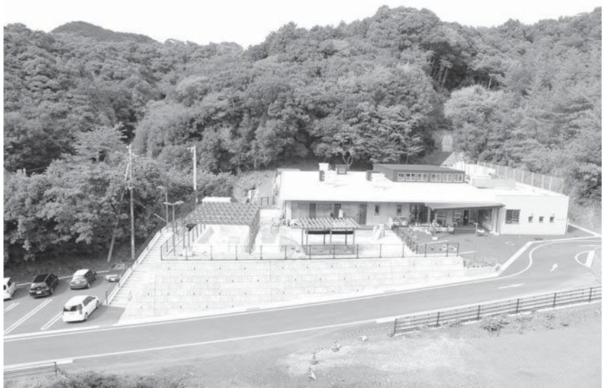
伊与喜小学校そばに建設された新佐賀保育所
