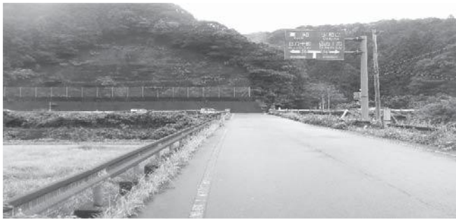
県道秋丸佐賀線から国道56号へ合流点が危険
