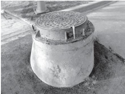
地震による液状化で浮上したマンホール の事例
