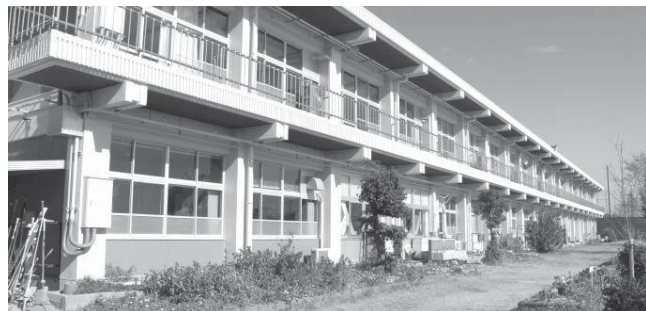
外回りもすっきりきれいになった入野小学校(1月7日)
