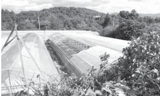
園芸ハウス屋根災害
