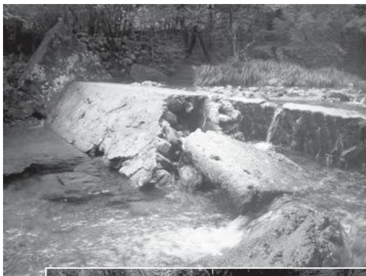
被災した市野瀬(上)と蜷川(下)の取水用堰の頭直工
