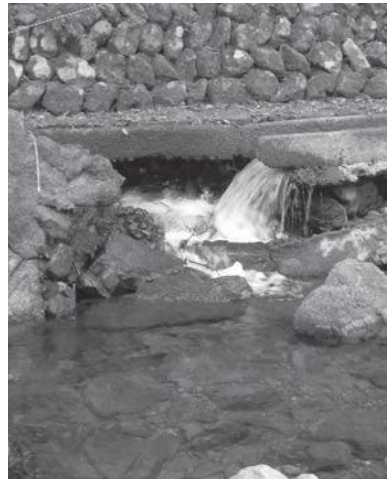
被災した有井川の用水路
