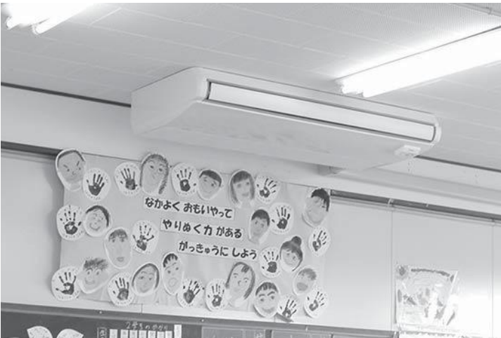
整備された空調設備(入野小学校)
