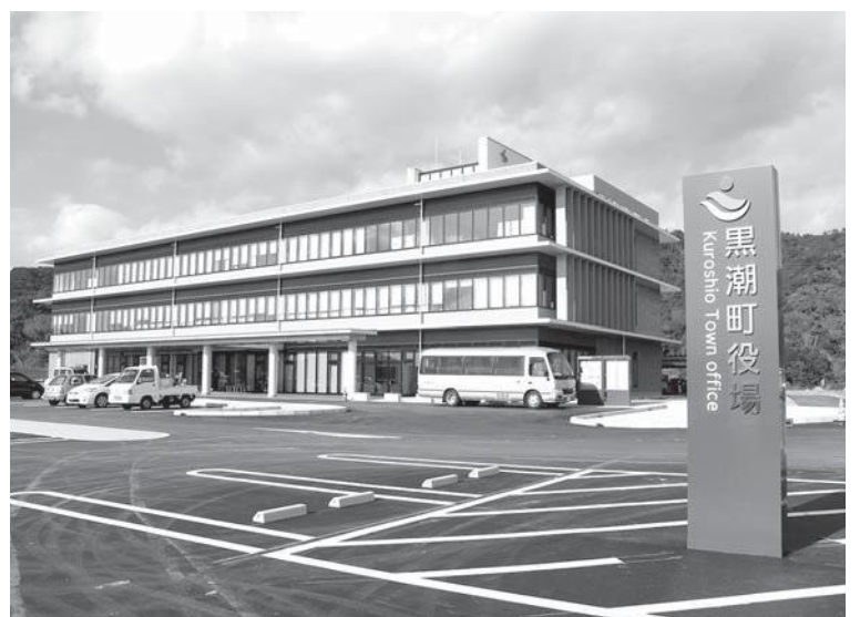
海拔高26mの高台に移転新築され、平成30年1月からサービスを開始した本庁舎。この新庁舎関連の総工事費は42億余で、この内、町の実質負担は4億6千万円弱を想定している
