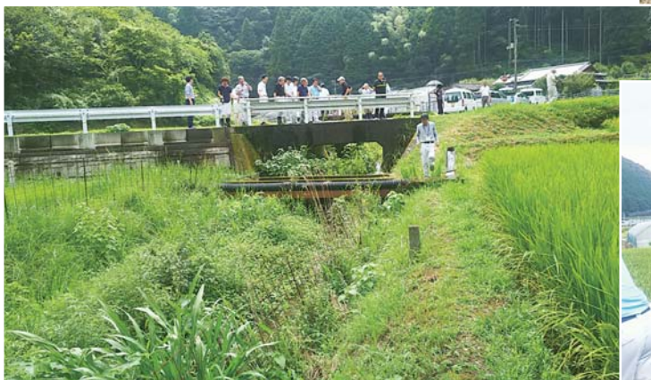
▲宮木砂防流路工の土砂除去(市野々川)
