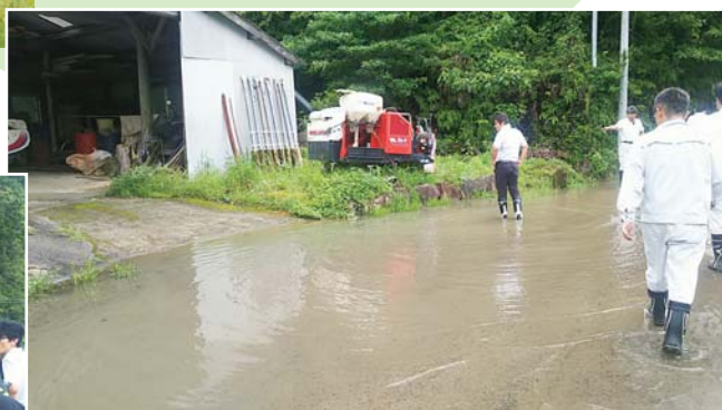
▲排水路の設置。当日は県道に水溜まりが(蜷川)
