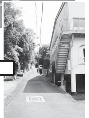
田野浦集会所(下)より田野浦避難集会所(上)までの間の町道部分の整備を予定
