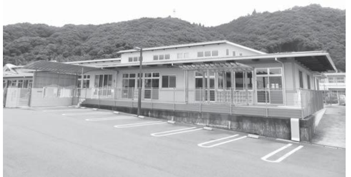
全室の利用計画がある旧佐賀保育所の全景
