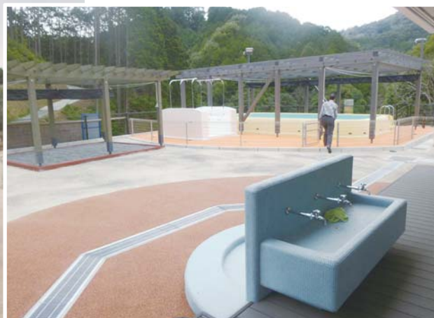
▲園舎南側に設置された手洗い場。奥側は砂場、シャワー、プールです
