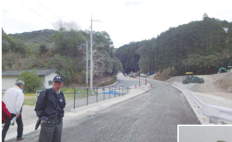
▲保育所への進入路。工事中でした
