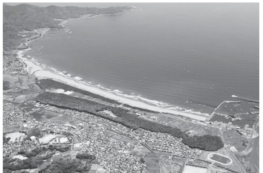
ドローンによる入野海岸の空撮写真
