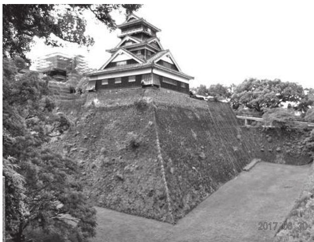
被害のなかった石垣と宇土櫓 左奥には修復中の天守閣が望める
