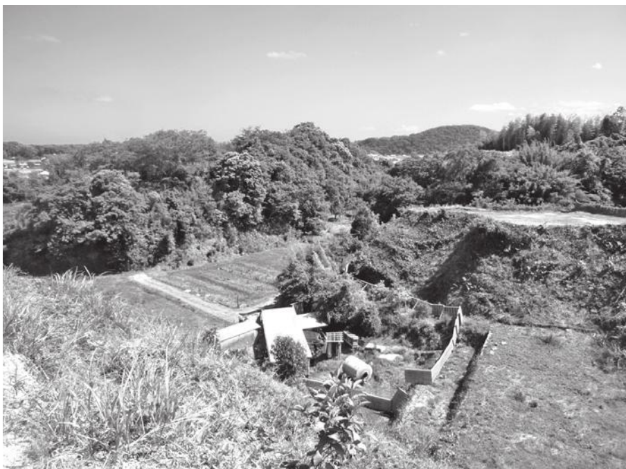
盛土工事予定の井ノ谷(中央部) 左側の木立部分は壇上公園
