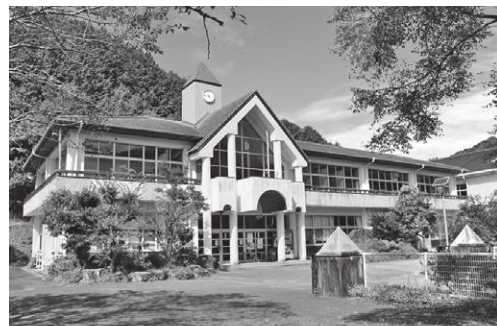
集落活動センター整備予定の旧馬荷小学校
