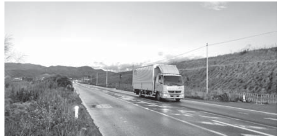
海岸近くを通る国道の東側から西側を。右側(山側)には盛土が続いている。左側(海側)は公園区域で盛土はしていない。
