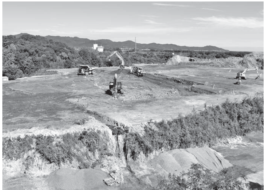
新庁舎建設に向け、用地の切土工事から庁舎基礎工事(中央部)へと順次進んでいる。右奥には井の岬も望める(10月6日撮影)
