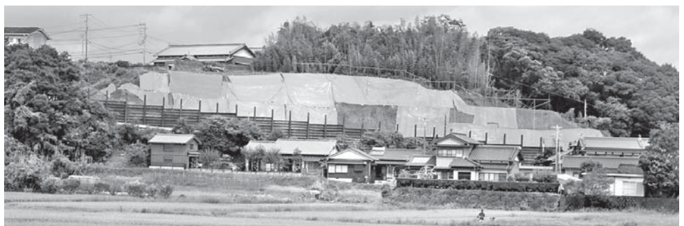
弘野団地避難道工事(7月11日撮影)
