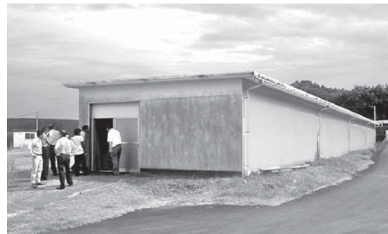
漁船漁業用作業施設(灘漁港)
