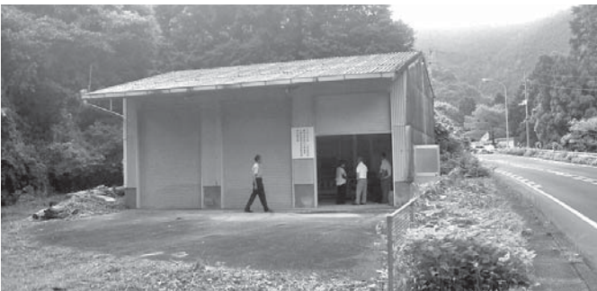
農林業基盤整備用機械施設(不破原)
