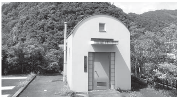
漁業集落排水事業施設の鈴クリーンセンター
