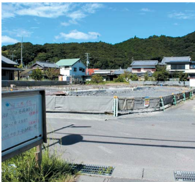
佐賀避難タワー建設は、大規模な基礎工事も終了し、来春の完成を目指して建方工事が始まります。
