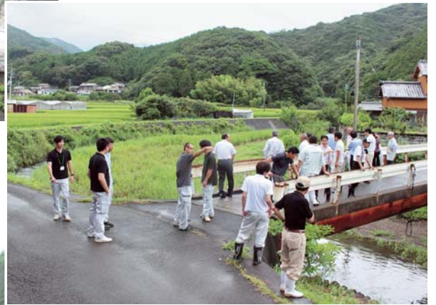
▼ 新田橋上東側の土手の改修要望箇所を。住民が思いを伝える場面も。(有井川)
