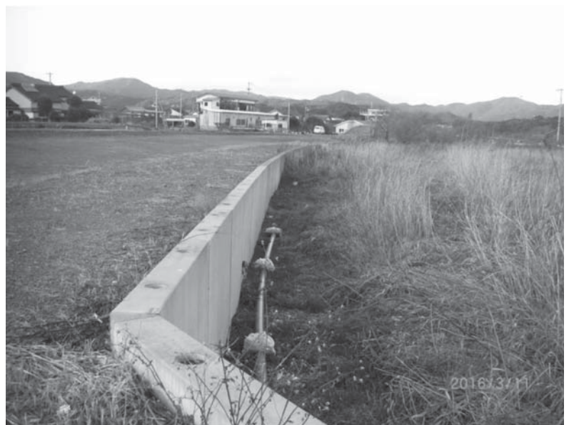
大方バイパス暫定工事中の用排水路
