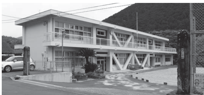
集落活動センターの設置計画がある旧蜷川小学校
