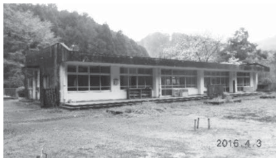
平成28年度解体が決まった旧伊与喜保育所
