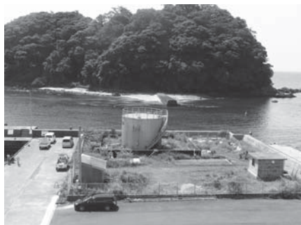
埋設化予定の給油タンク（中央部）
