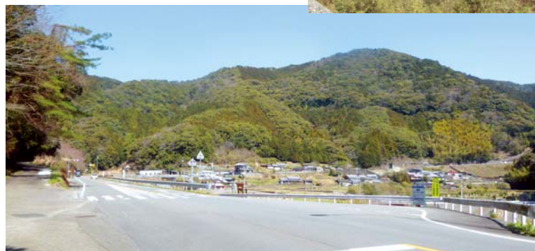
▲黒潮町の東の玄関口、片坂の上り口に位置する市野瀬地区
