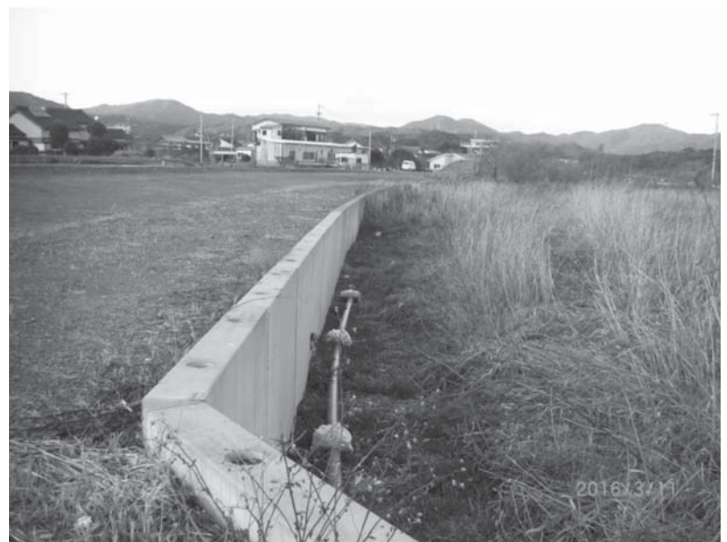
大方バイパス暫定工事用の排水路
