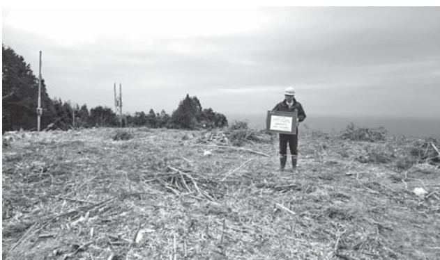
鈴地区のヘリポート建設予定地
