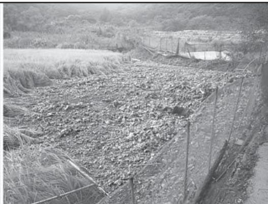
路肩崩壊などによる水田への土砂の流入が（共に伊田郷地区）
