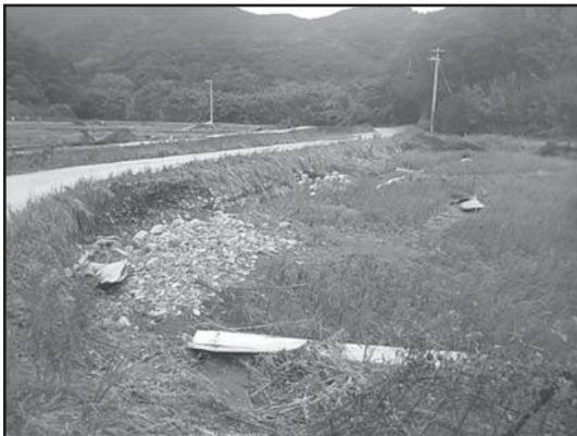
路肩崩壊などによる水田への土砂の流入が（共に伊田郷地区）
