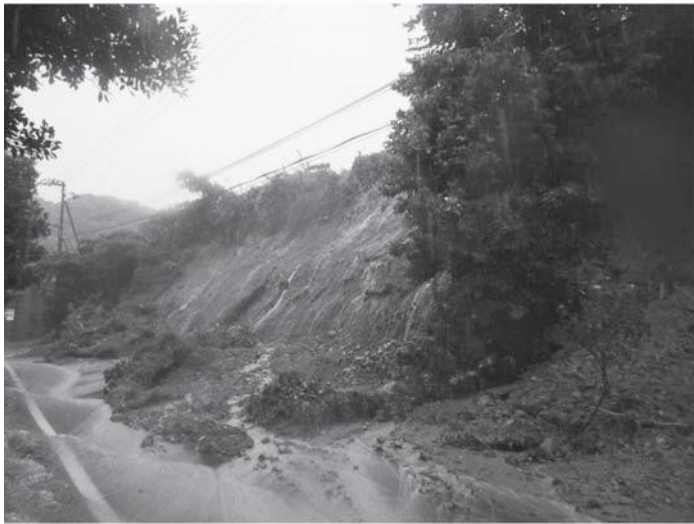
町道王無線法面の土砂くずれ (上川口地区)
