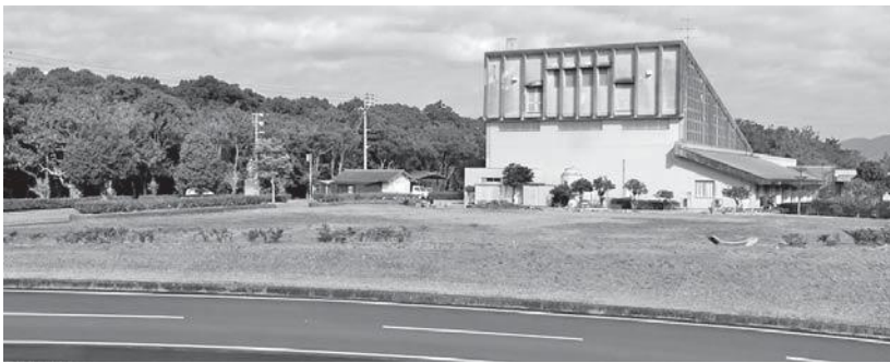
津波避難施設兼展望台の設置場所(ふるさと総合センター西側)
