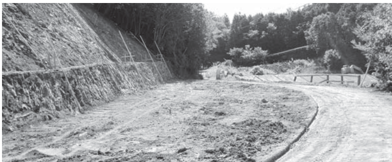
町道成又熊野浦線の道路改良工事中です
