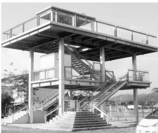
万行地区に設置されている津波からの避難タワー
